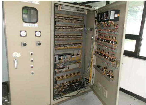
손상내용 현장제어반 상태양호 손상원인 -
