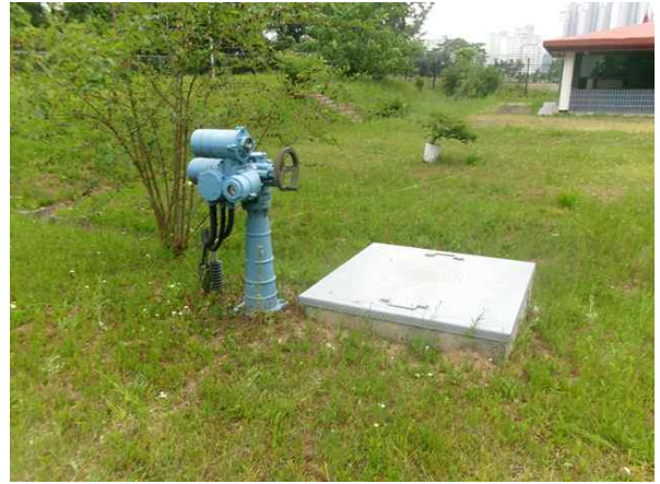
환기구 등의 덮개(장비 반입구) 현황
