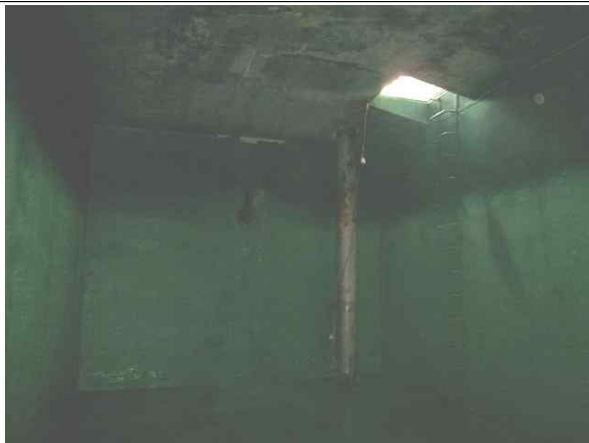
배수지 1지 내부 전경
