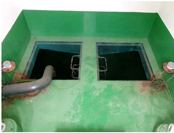
검수실 내부 전경
