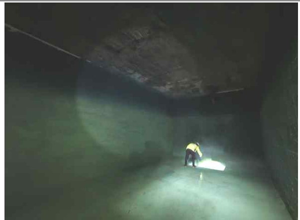
배수지 2지 내부 전경
